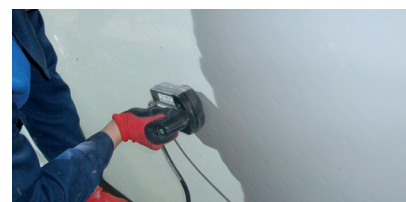
Induktofix® заваръчен диск за мембрани AGRU
